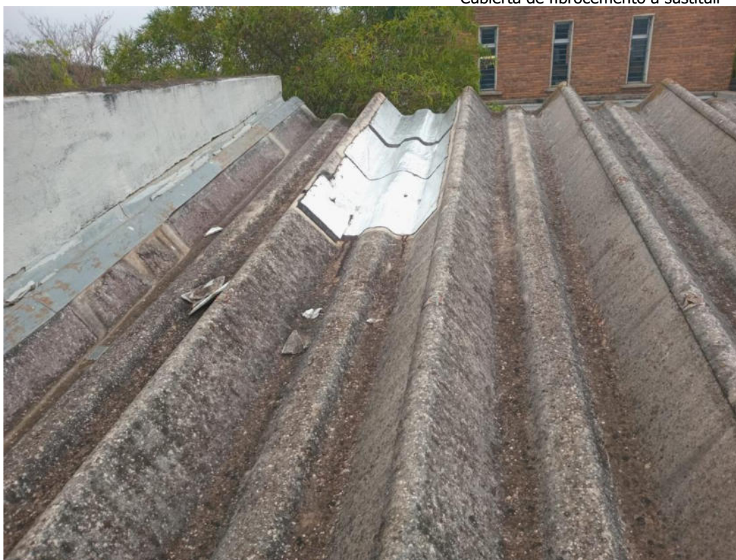
Cubierta de fibrocemento a sustituir
