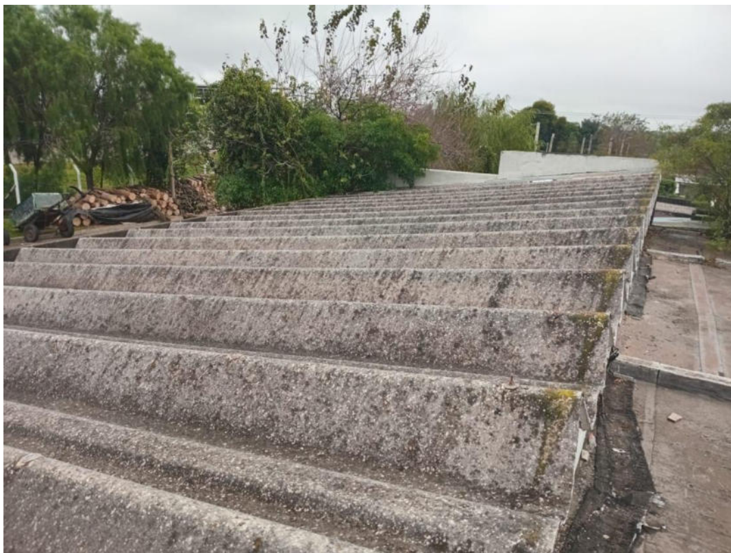
Cubierta de fibrocemento a sustituir
