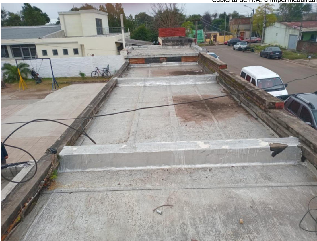
Cubierta de H.A. a reimpermeabilizar
