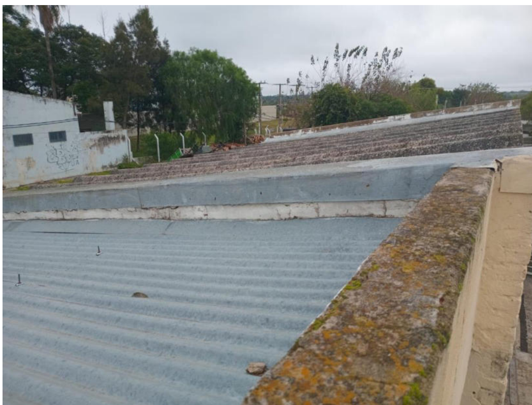
Cubierta de chapas. Pretiles y babetas a reparar
