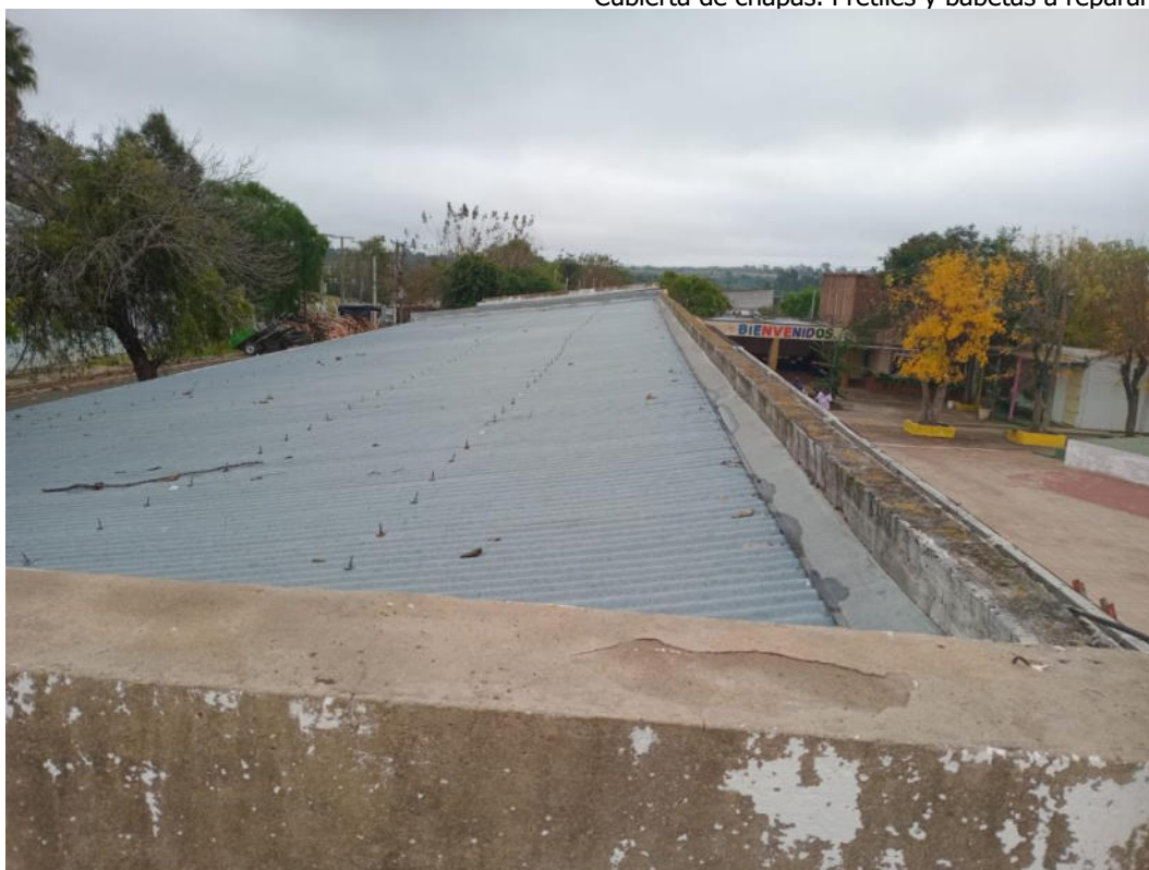
Cubierta de chapas. Pretiles y babetas a reparar
